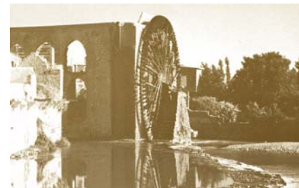
E. Aqueducts al Riu Orontes (Turquia)
