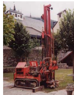
Fotografia 1: Sonda de perforació TP-50.
