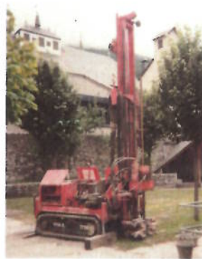
Fotografia 1: Sonda de perforació TP-50.
