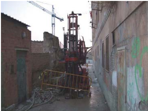
Fotografia 3: Emplaçament del sondeig S-2.
