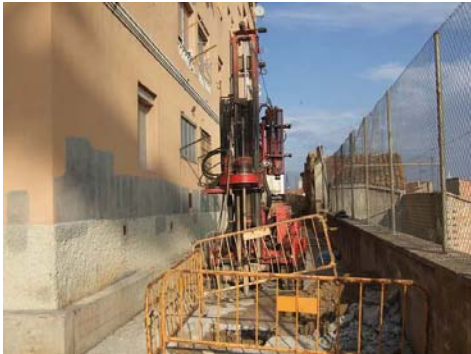
Fotografia 2: Emplaçament del sondeig S-1.
