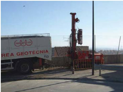
Fotografia 4: Emplaçament del sondeig S-3.
