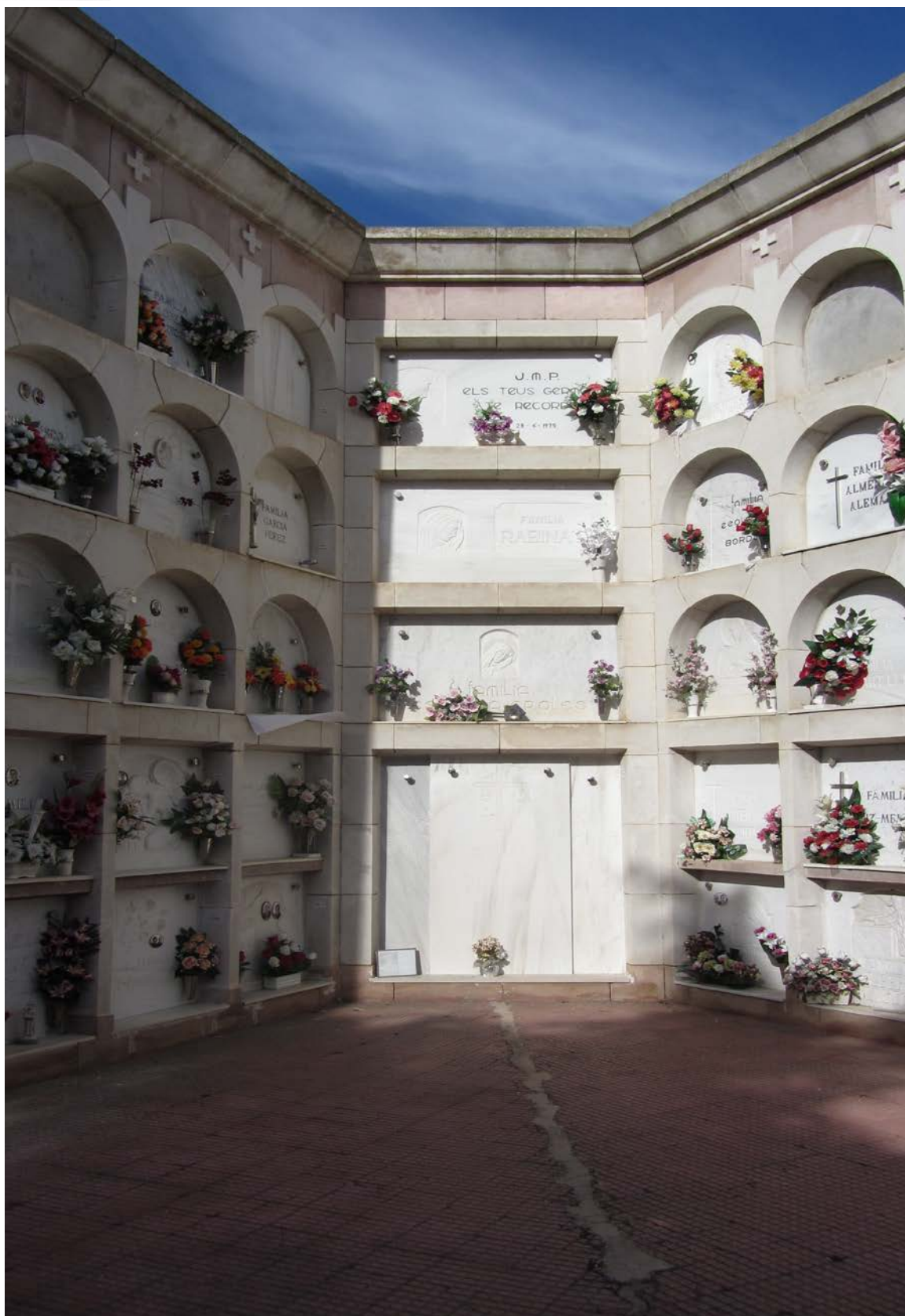
VISTA DE LA ZONA AFECTADA PER L' OBERTURA DEL PAS DE COMUNICACIÓ ENTRE Ntra. Sra. DE MONSERRAT I DPT. DE SANT CRIST.
