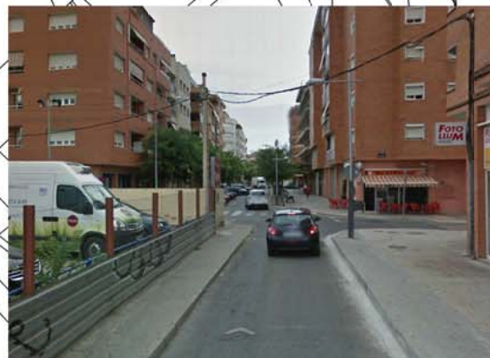
Desmuntatge i retirada tanca metàl·lica amb malla de simple torsió i xapa grecada col·locada amb perfils metàl·lics IPN-120
