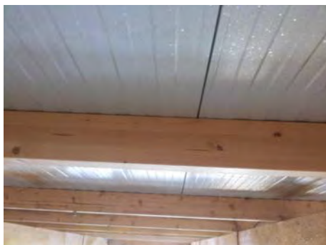
Figura 1. Biga de fusta laminada encolada
