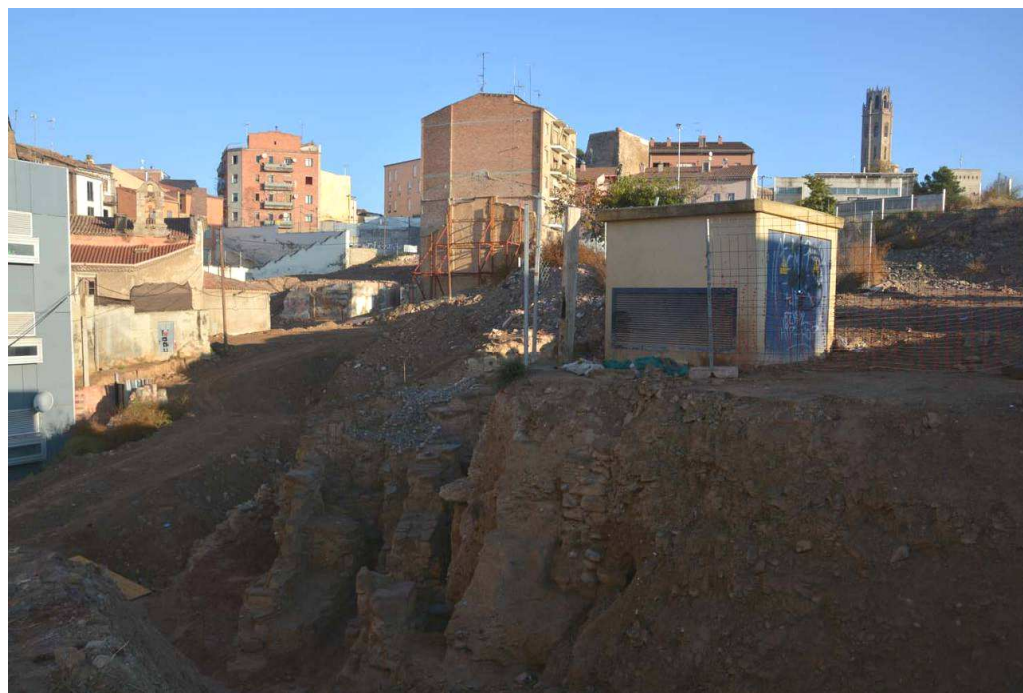
Observis com el transformador està construït sobre els sediments que acabaren cobrir les restes del call jueu.
