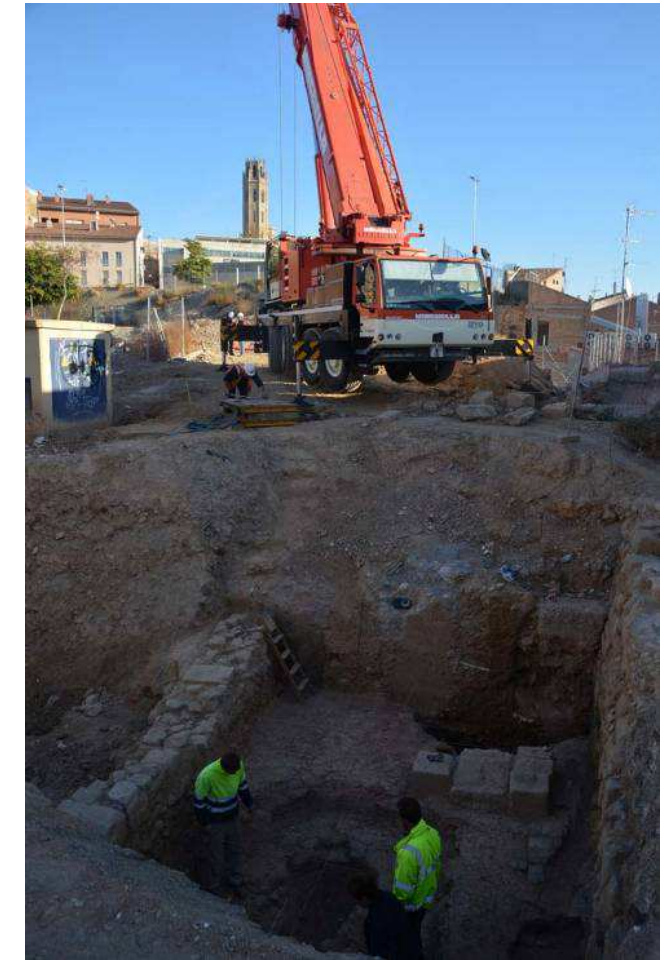
Detall del moment d'extracció del transformador. En primer terme la zona 1 ja finalitzada
